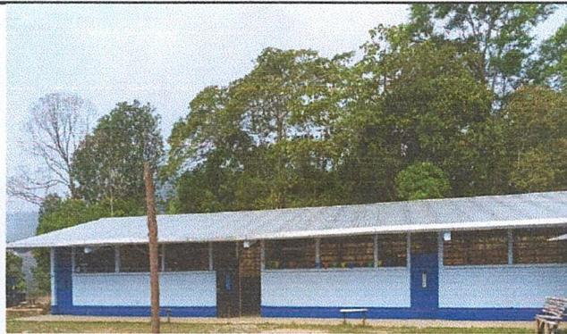
Foto 3: Cambio de cubierta de lamina troquelada calibre 26 Modulo 1
